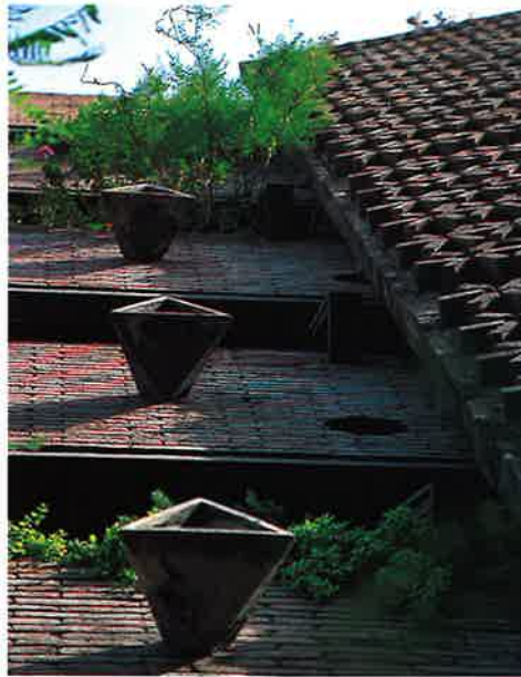
Appartementengebouw van R. Bofill in Barcelona (1965): bijzonder gebruik van baksteen in scherm rechts, waarachter zich de keukens en badkamers van de woningen bevinden
