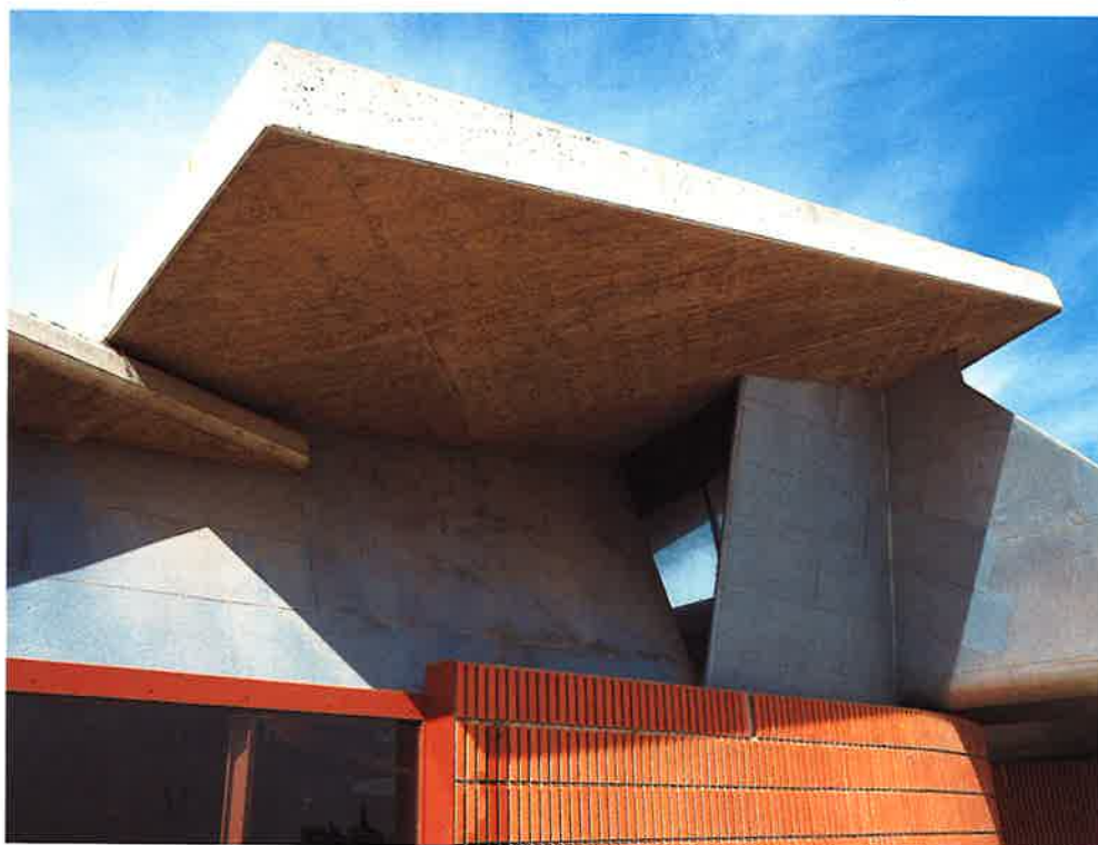
Detail kleedruimten bij boogschutterbanen in Vall d'Hebron, Barcelona, van E. Miralles en C. Pinós (1992)
