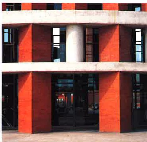
Detail van entree en hal station Atocha: gelijmde baksteen
